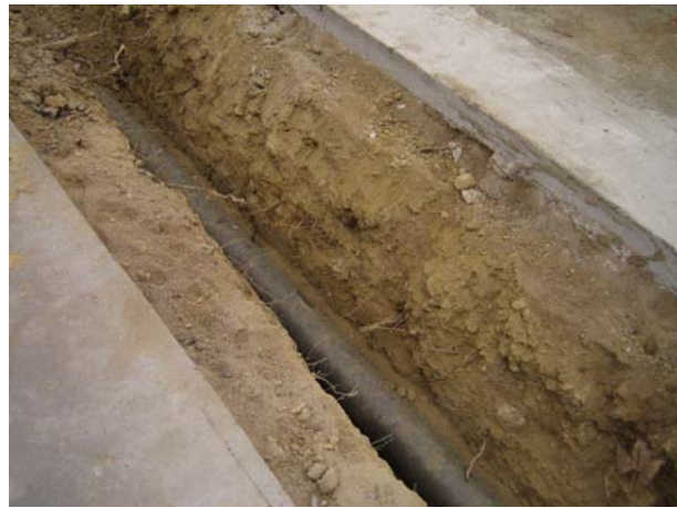
FOTO 2. Vista en detall d'un tram de la rasa
