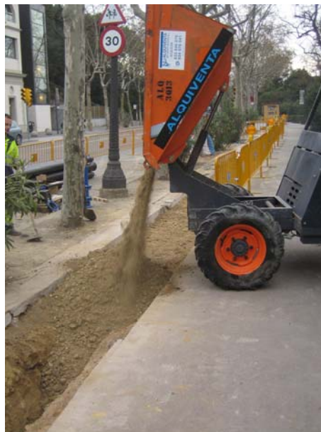
FOTO 3. Vista del procés de rebliment de la rasa
