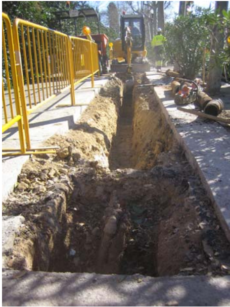
FOTO 1. Vista del procés d'obertura de la rasa
